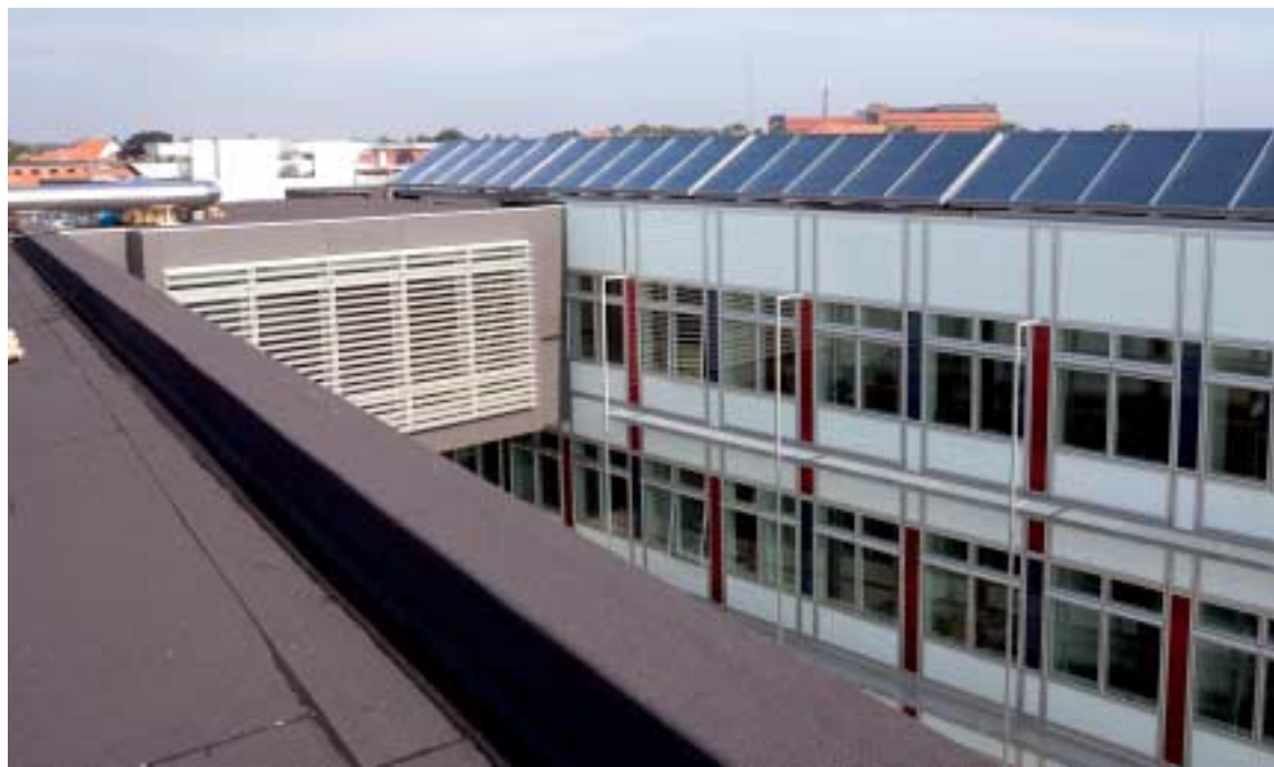
Rådhuset forsyner sig selv med varme til både rum og vand - bl.a. fra 265 kvadratmeter solfangere på taget.
