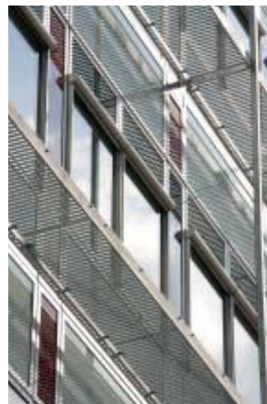
De store glasfacader er udvendigt forsynet med faste pudsebroer - til glæde for vinduespudseren.
