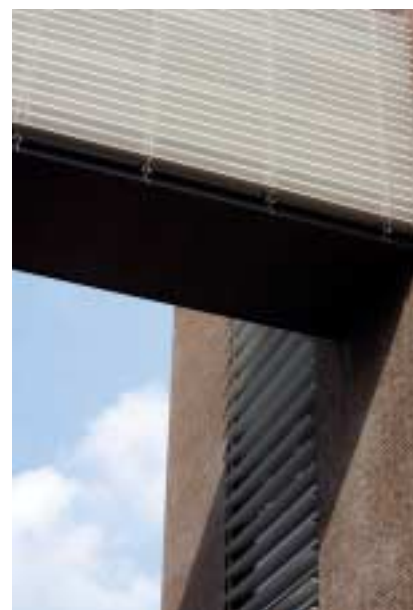
Glasfladerne på gangbroerne mellem bygningerne er forsynet med vandrette sollameller. Bygningen er udstyret med en kombination af naturlig og mekanisk ventilation - med Glenco A/S som ansvarlig for alt VVS-, ventilations- og sprinklerarbejde.
